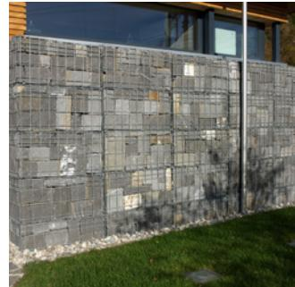
Werkseitig montierte, verfüllte und verdichtete Steinkörbe:
