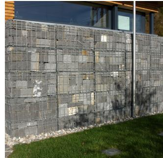
Werkseitig montierte, verfüllte und verdichtete Steinkörbe:
