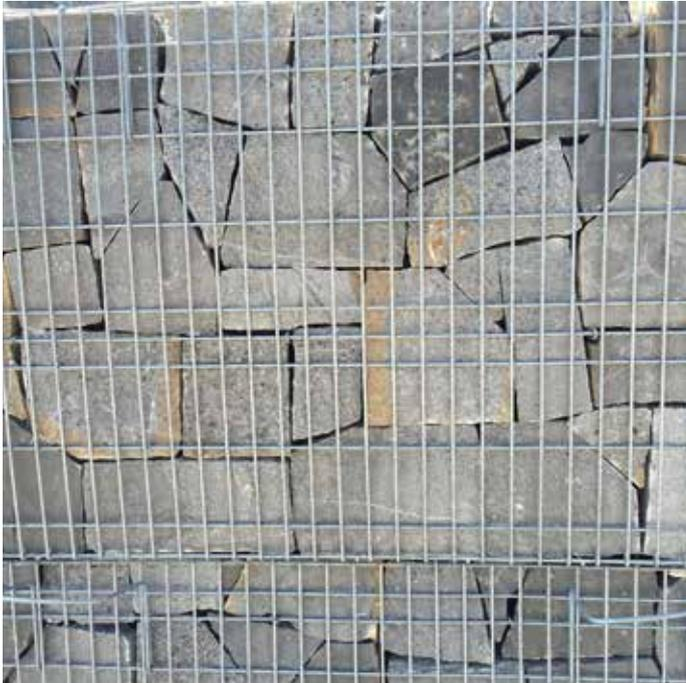
Werkseitig montierte, verfüllte und verdichtete Steinkörbe:
