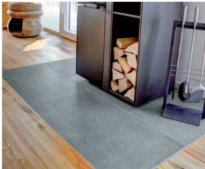
Bodenbeläge: gattergesägte Platten, wassergejetet und gebürstet
