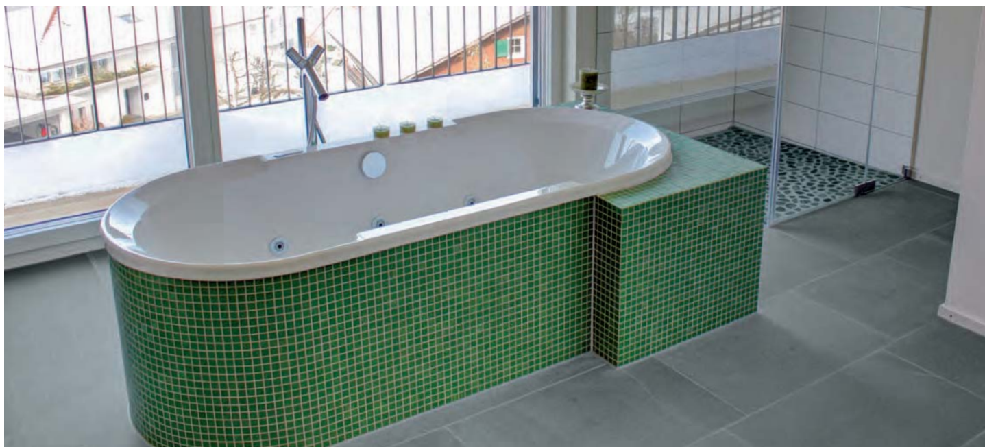
Bodenbeläge: gattergesägte Platten, wassergestrahlt und gebürstet – Bahnbreite 45 / freie L / 2cm stark
