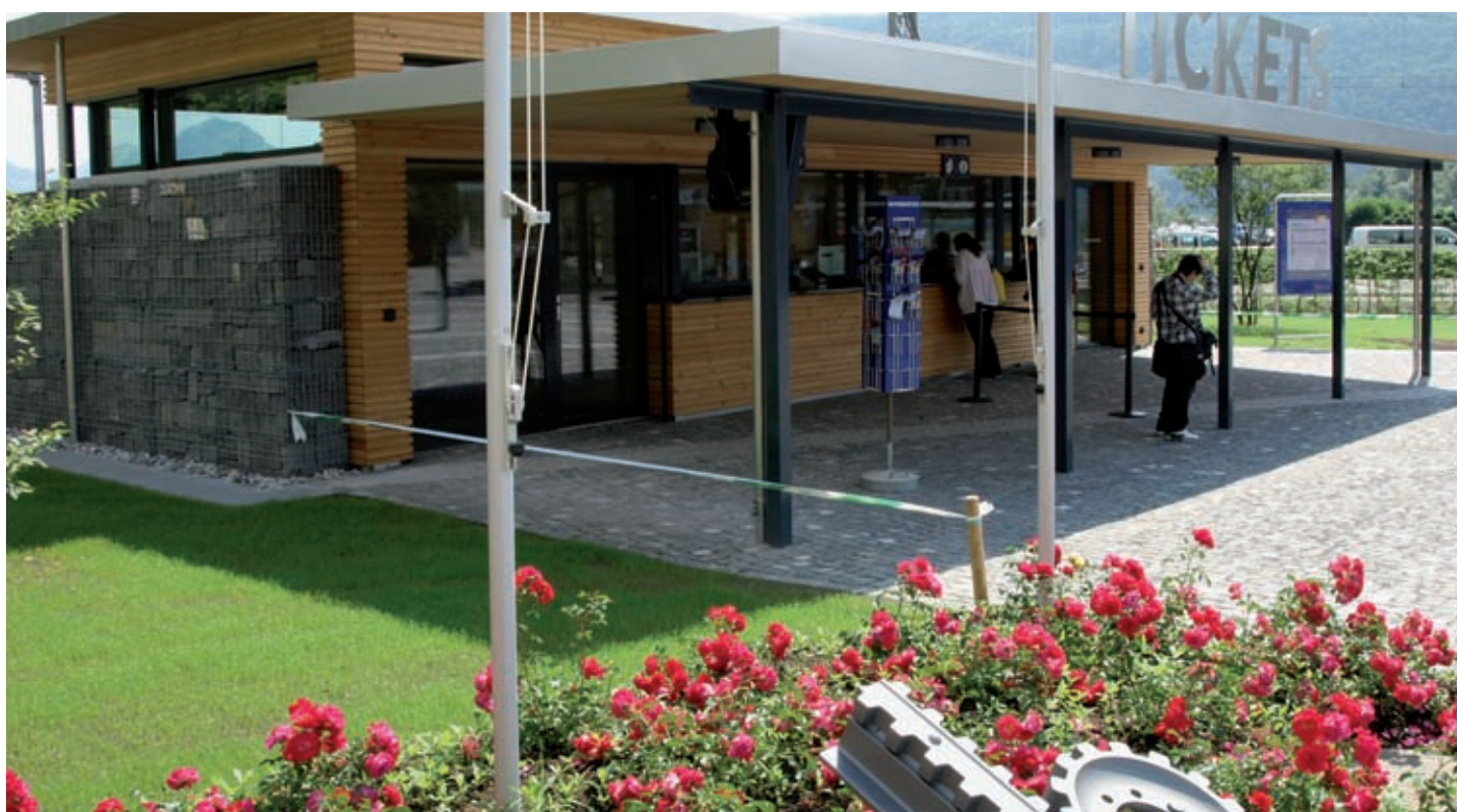
Edifice vente-billets à Alpnachstad
