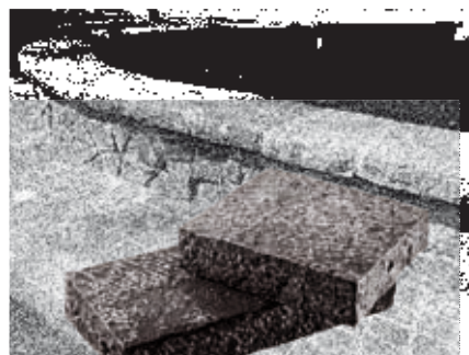
Couvertines de mur clivées, taillées grossièrement
